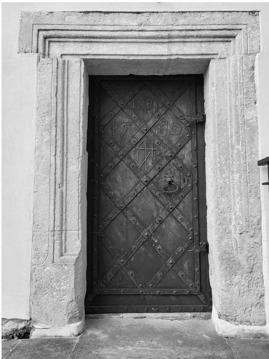
1. Żelazne drzwi w ścianie sanktuarium cerkwi w Szczepieszynie, fot. M. Ludera.
