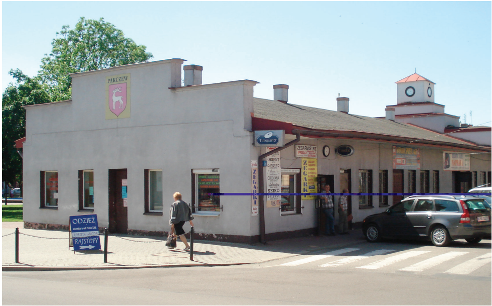
Fot. 3 i 4. Hala targowa w Parczewie – stan obecny. Fot. J. Żywicki 2013.
