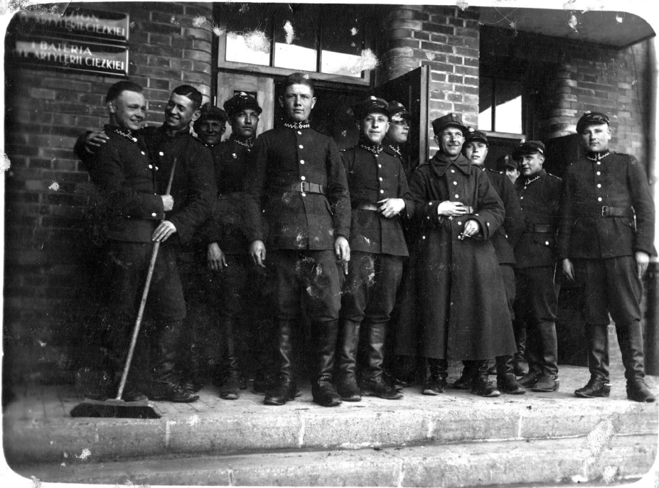
11. Żołnierze 9 PAC przed jednym z budynkiem koszar. W lewym górnym rogu widać napis 9 Pułk Artylerii Ciężkiej, 1 dywizjon artylerii ciężkiej.
